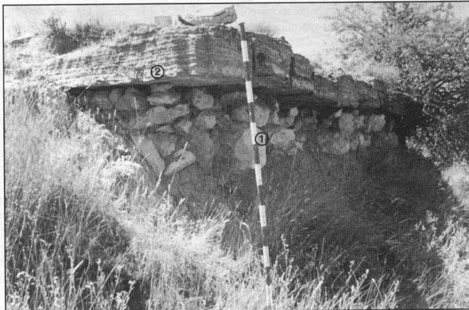
LÁM. 17.1. Detalle de la deficiente cimentación de la muralla Norte del «Durón» de Belmonte: con lecho de piedras irregulares directamente sobre la arcilla (1) y sillares sobre aquél (2).
